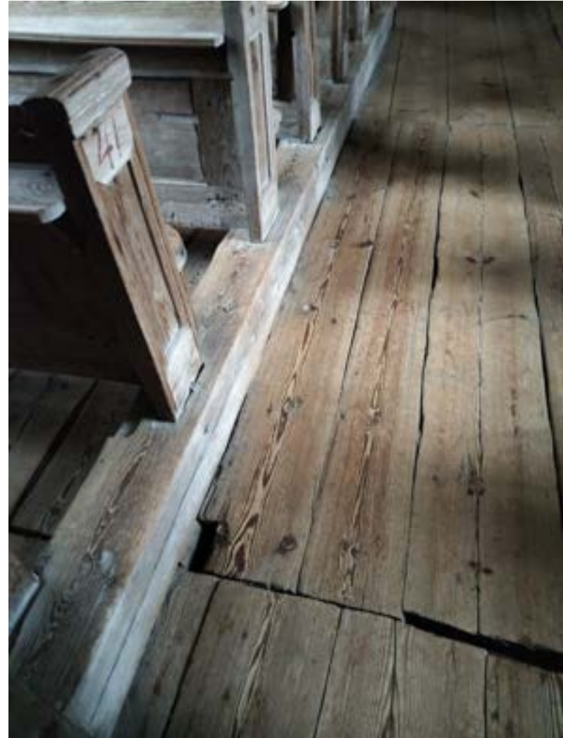
Kymmenen vuotta Loimaan emäkirkkoa myöhemmin rakennettu Petäjäveden vanha kirkko on edelleen liki rakennusaikaisessa asussaan, joten voimme ajatella yleisilmeen olevan varsin samankaltainen kuin Loimaan emäkirkko valmistuttuaan 1751.
