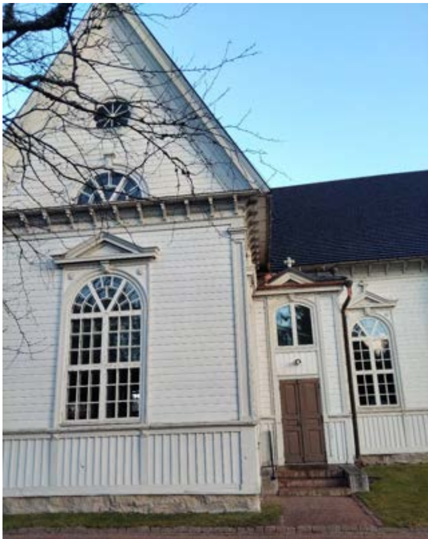
Julkisivuverhous on edelleen Josef Stenbäckin 1890-luvun puolivälissä suunnittelemassa muutosasussa. Stenbäckin lisäyksiä kirkon ulkoiseen massaan ovat oikeassa kuvassa näkyvä monikulmainen sakaristo, ja sakariston ja kuorin sekä ristikaroiden eteläpuolisiin kulmiin jäävät pikkueteiset, jotka samalla toimivat porraskäytävinä ristikaroiden parville.
