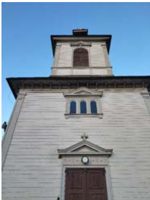
Vasemmalla: Torni kuvattuna etelästä. Torni lisättiin kirkon eteläpuolelle 1841. Julkisivu muutettiin nykyisen kaltaiseksi 1895-96.
