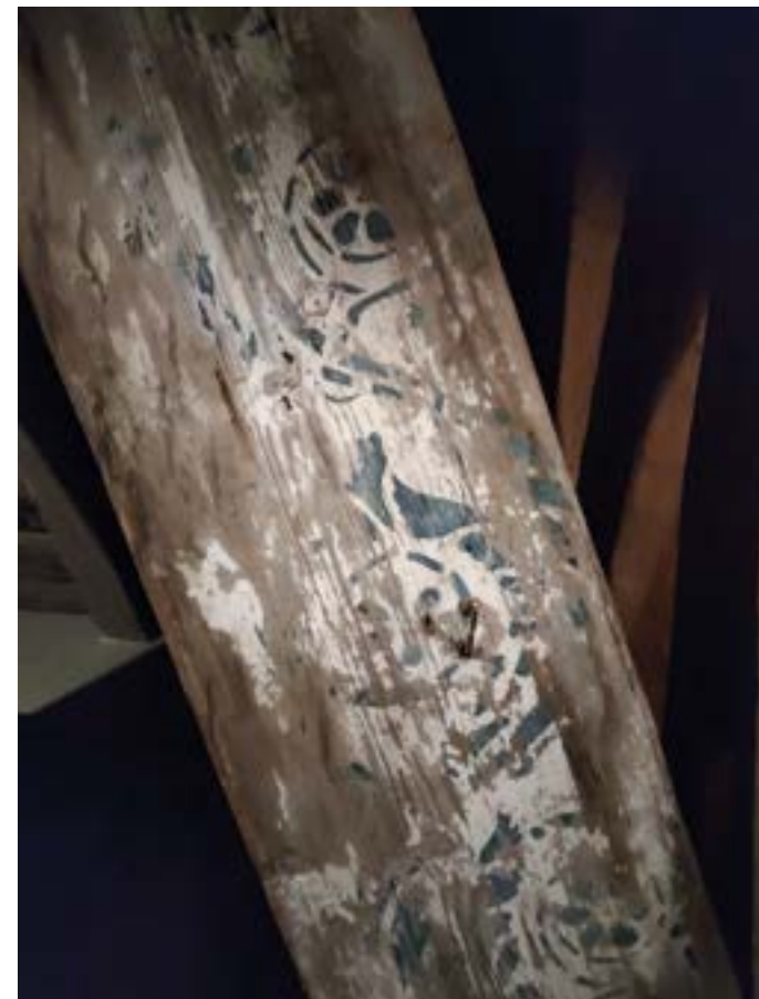
aiemmin sidehirret. Nämä hirret olivat Aaltoyliopiston arkistossa säilytettävän valokuvan mukaan (s. 32) koristetut samoin kuin kattojen alareunat. Valokuvissa 1895 ei enää näy sidehirsiiä vaan sideraudat. Näin ollen on mahdollista, että kelloja kannattavat rakenteet on uusittu samoihin aikoihin ja materiaalina käytetty em sidehirsiiä.
