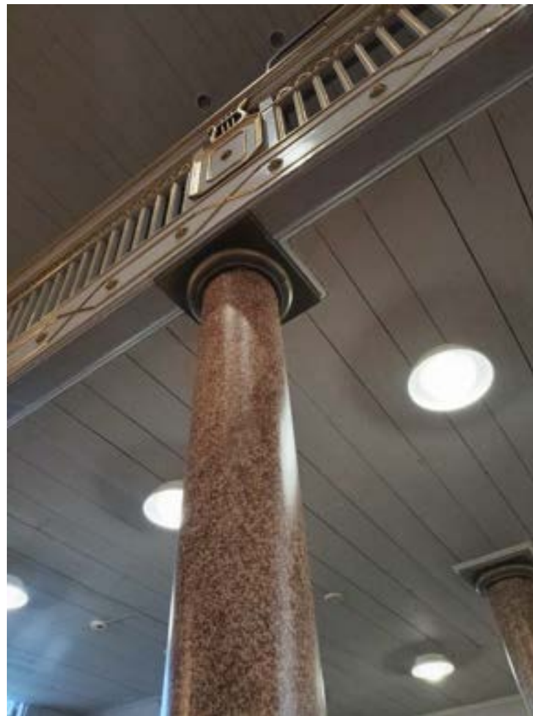
näkyvät penkit ja oikealla näkyvät alakaton ja parven alakaton paneeloinnit ovat Josef Stenbäckin suunnitelmien aikaiset, 1890-luvun loppupuolelta. 1800-luvun puolivälissä alttarin pilarit, todennäköisesti myös alttarikaide ja parven pilarit, olivat valkoiseksi marmoroidut.
