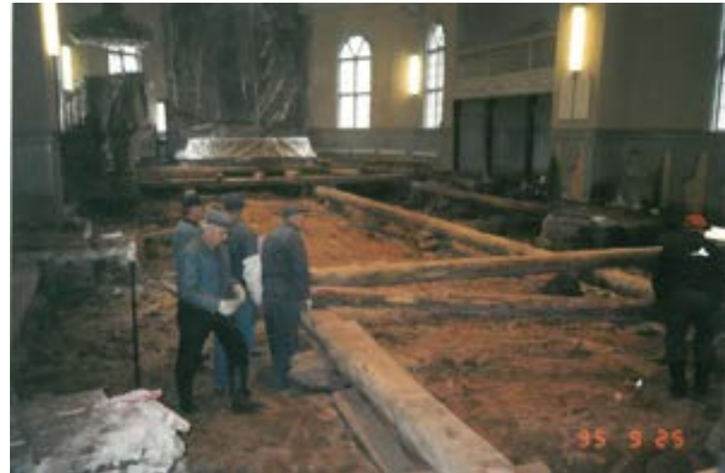
Valokuva 25.9.1995. Kirkon alapohjan korjaus. Loimaan kunta. Jaakko ja Tuulikki Mäkimattilan arkisto.
